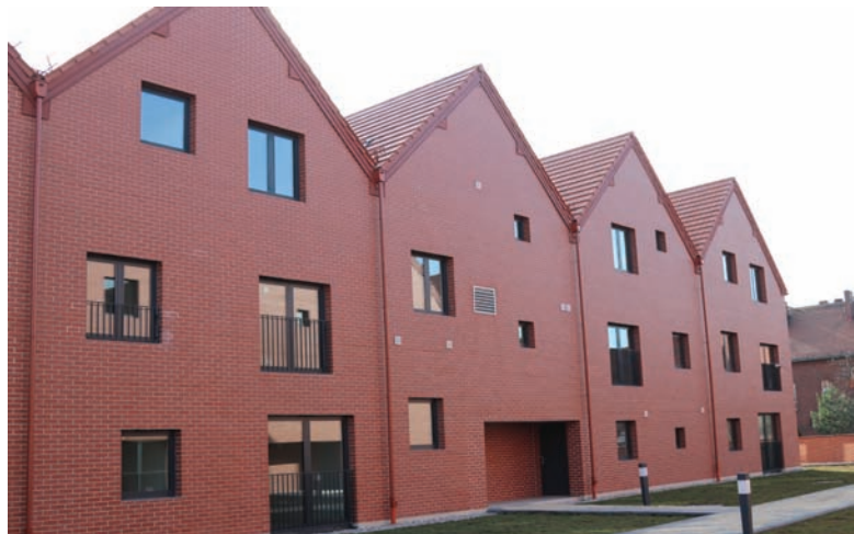
Budynek mieszkalny przy ul. Bankowej w Rudzie.
