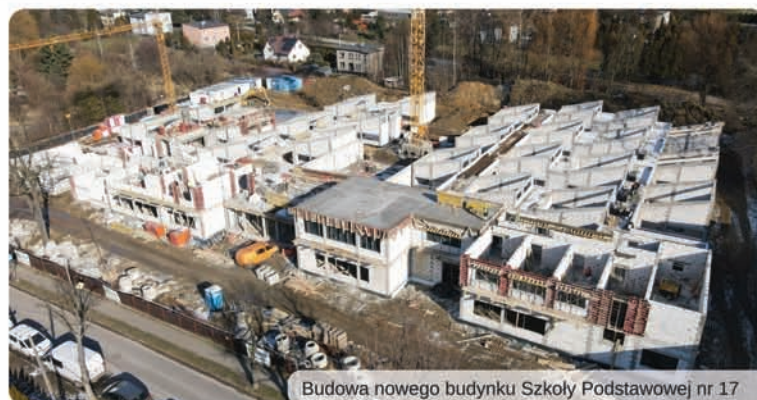
Budowa nowego budynku Szkoły Podstawowej nr 17
