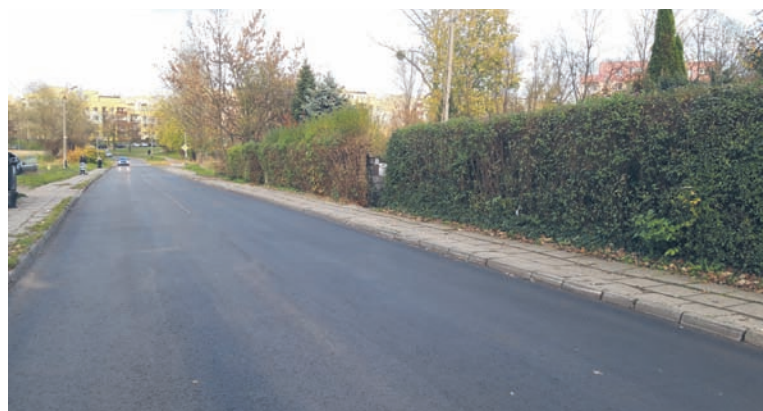
Remont ulicy Zietka sfinalizowany został pod koniec października.
