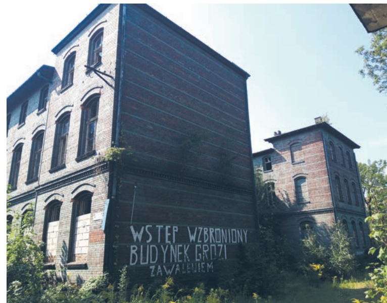
Budynek dawnego szpitala w Wirku zamienia się w ruinę, choć miał mieć świetlaną przyszłość.
