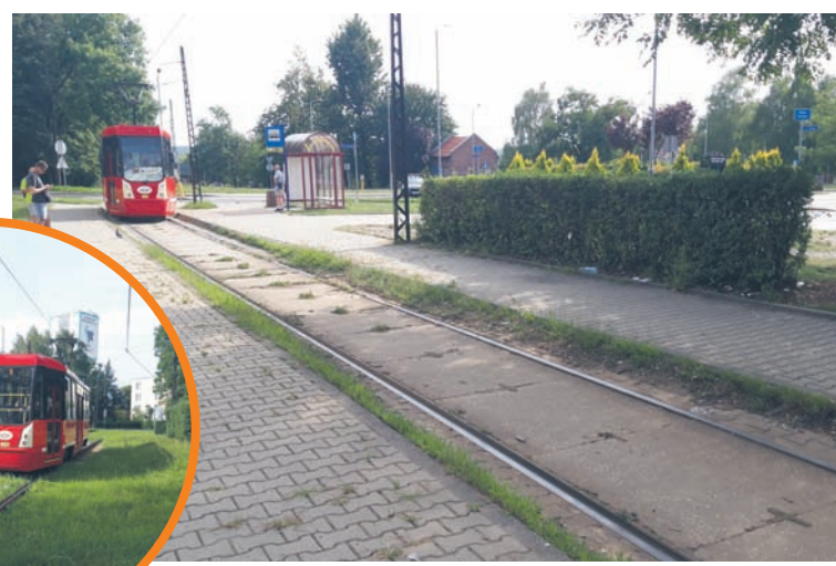
Remont na odcinku linii nr 9 od podstacji Wirek do mijanki KWK Pokój kontynuowany będzie w pierwszy weekend września.
