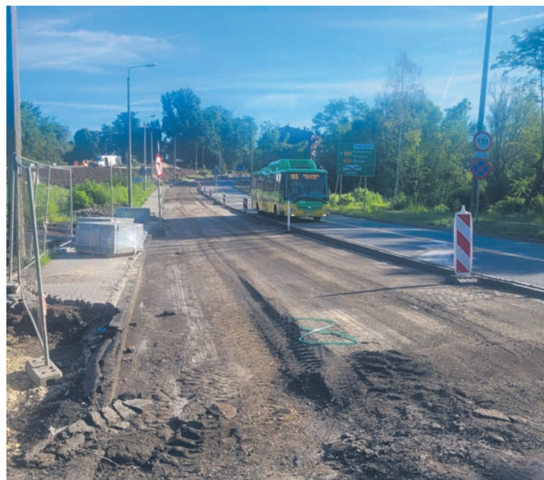
Z uwagi na postępujące prace na placu budowy konieczne było zawężenie ulicy 1 Maja w kierunku Halemby.
