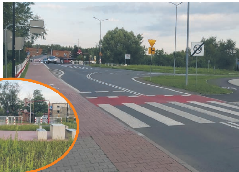
Inwestycja objęła nie tylko przebudowę dróg, ale również m.in. utworzenie ciągów pieszo-rowerowych.
