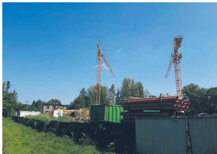
Budowa nowej siedziby SP nr 17 wstrzymana została w lutym br.
