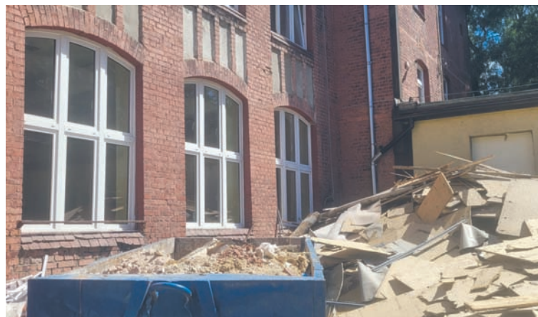
W trakcie tegorocznych wakacji prace przeprowadzane są w budynku SP nr 7.
