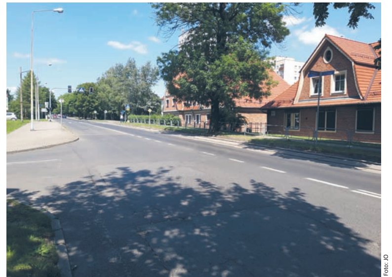
W ramach prac wymieniona zostanie konstrukcja drogi, a jej geometria skorygowana.
