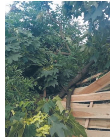
Spadające konary połamały ogrodzenie działek zlokalizowanych przy ul. Akacjowej. Zdjęcie nadesłane przez Czytelnika.
