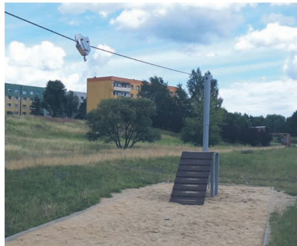
Tyrolka w strefie aktywności rodzinnej w Bykowinie zdemontowana została z powodu wad konstrukcyjnych.
