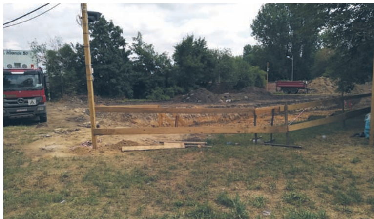
Na placu budowy prowadzone są obecnie pierwsze roboty ziemne.
