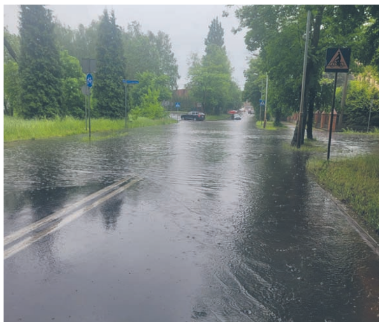
Zalewisko utworzyło się m.in. przy ul. Nowary w Wirku. Część kierowców zdecydowała się zawrócić w tym miejscu i pojechać inną drogą.
