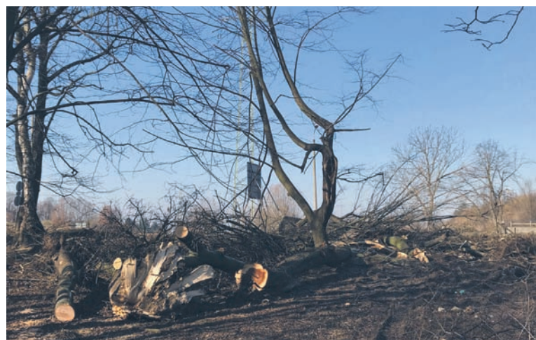
W związku z budową trasy konieczna była częściowa wycinka drzew.
