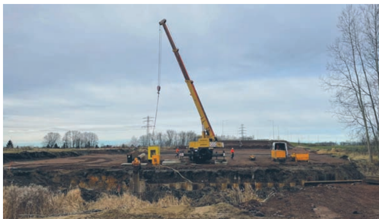
Na początku grudnia ubiegłego roku rozpoczęła się budowa obiektów inżynierskich oraz wykonano wzmocnienia nasypów.
