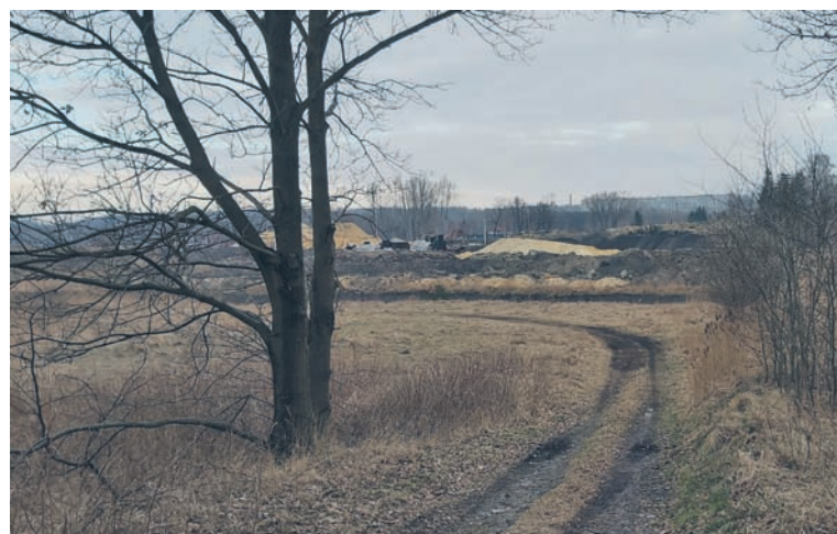
Postęp prac można śledzić m.in. od strony ulicy Mostowej w Wirku.
