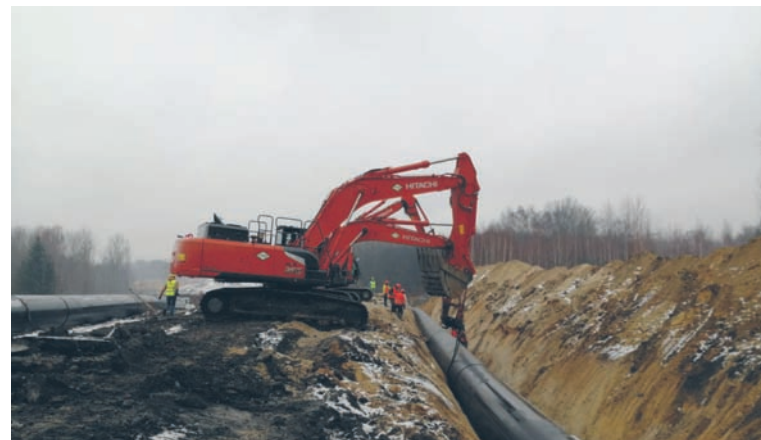
Budowa czwartego odcinka trasy N-S ma zakończyć się w listopadzie 2023 r.
