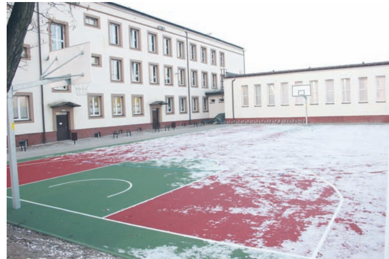
Przy SP nr 24 zrealizowano tzw. zadanie duże, czyli budowę boisk do piłki nożnej i koszykówki.
