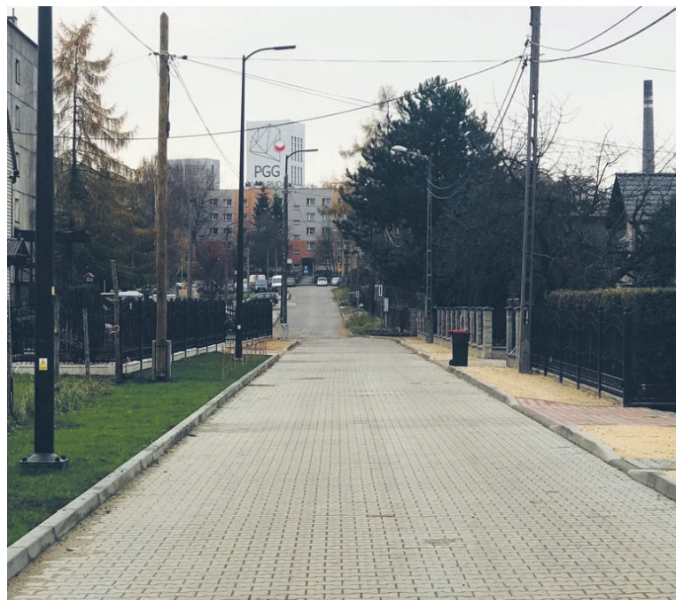
W ramach modernizacji nie tylko utwardzono drogę, ale wybudowano kanalizację deszczową i sanitarną oraz oświetlenie LED.
