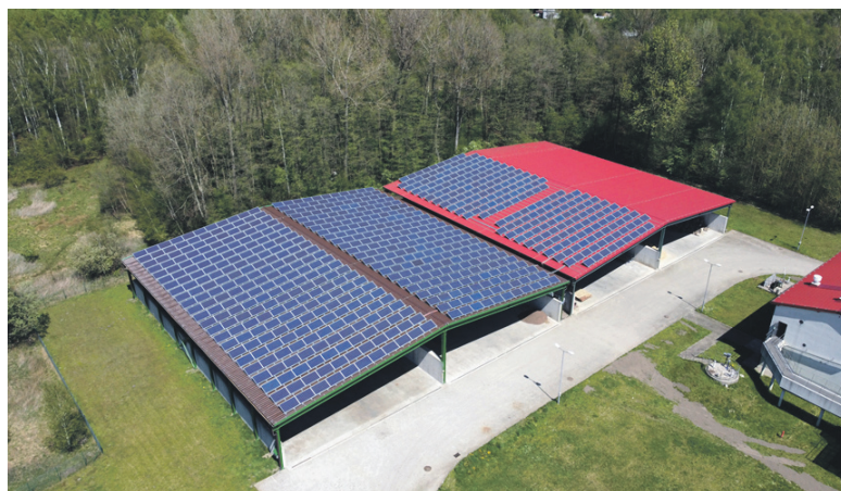
Panele zamontowano na zadaszeniu poletka osadowego.
