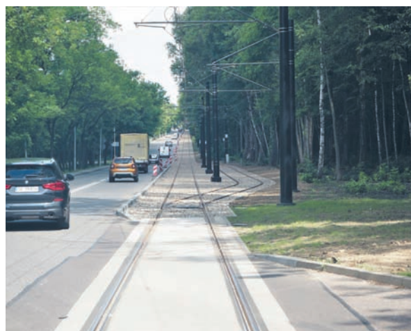
Stan torowiska przy ul. Karola Goduli przed i po modernizacji.
