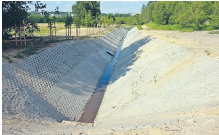
W ramach prac m.in. zbudowano zbiornik retencyjny i rów odwadniający.
