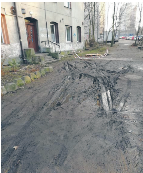
Tak po opadach deszczu wygląda dojście do kamienicy.
