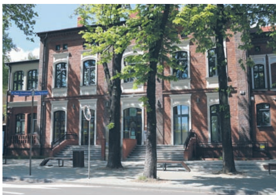
Po remoncie budynek stał się reprezentacyjną perełką Nowego Bytomia.
