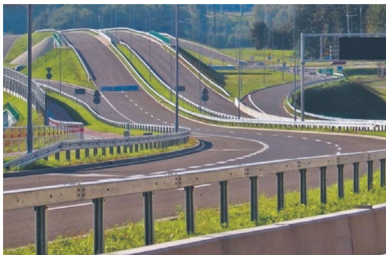
Dotychczas dziewięć firm rozpoczęło działalność przy trasie N-S w Rudzie Śląskiej.
