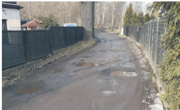
Mieszkańcy m.in. ul. Nowowiejskiej muszą poczekać aż drogi obesuschną, wówczas ubytki będą uzupełniane.
