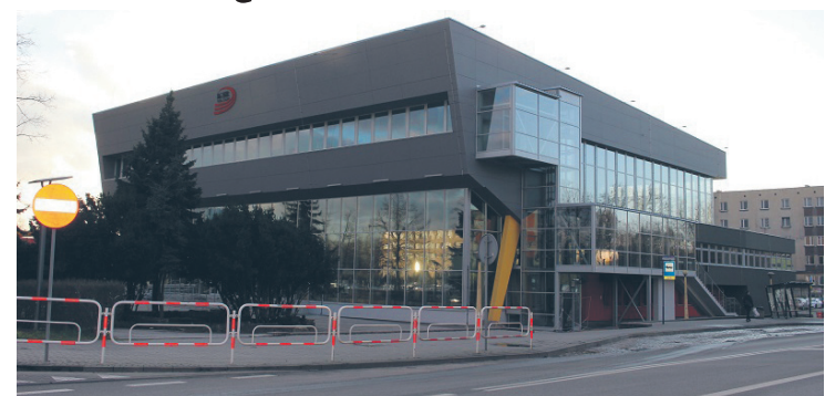
Obecnie trwa przetarg m.in. na remont sanitariatów i instalacji sanitarnych. Wewnątrz hali rozpoczną się również inne prace.
