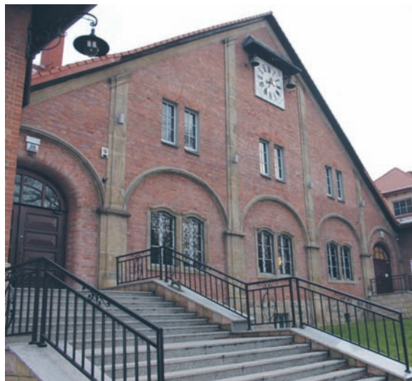
W ramach prac m.in. odnowiono elewację budynku.
