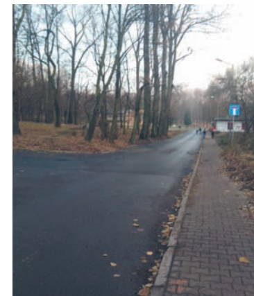
Remont drogi został przeprowadzony w drugiej połowie listopada.
