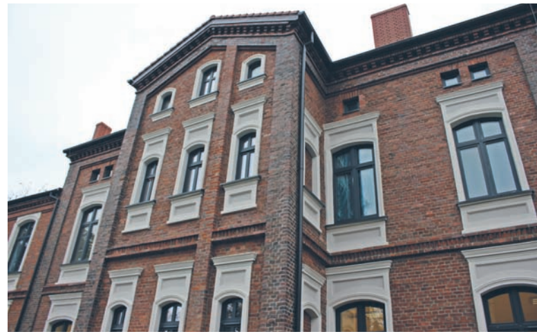
W ramach prac prowadzonych przez MPGM TBS Sp. z o.o. m.in. odnowiona została elewacja.
