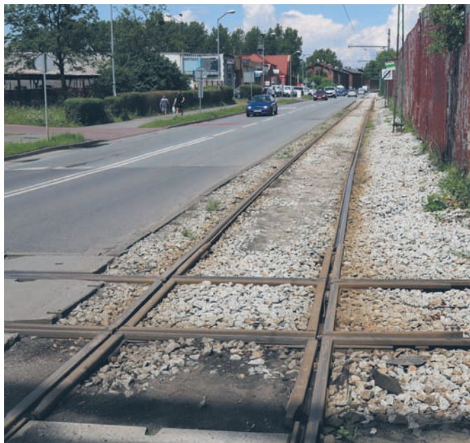
Zmodernizowano ok. 200-metrowy odcinek torowiska przy Hucie Pokój.
