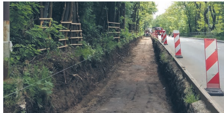
Obecnie wzdłuż ulicy Goduli trwają prace ziemne.
