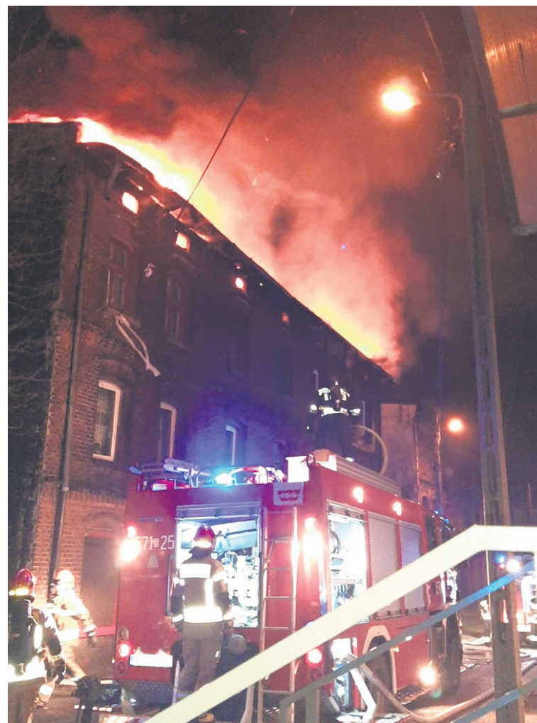
W wyniku pożaru spalił się dach kamienicy.
