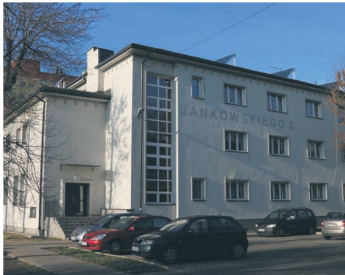
W 2018 roku udało się zrealizować termomodernizację budynku przy ul. Jankowskiego 8.
