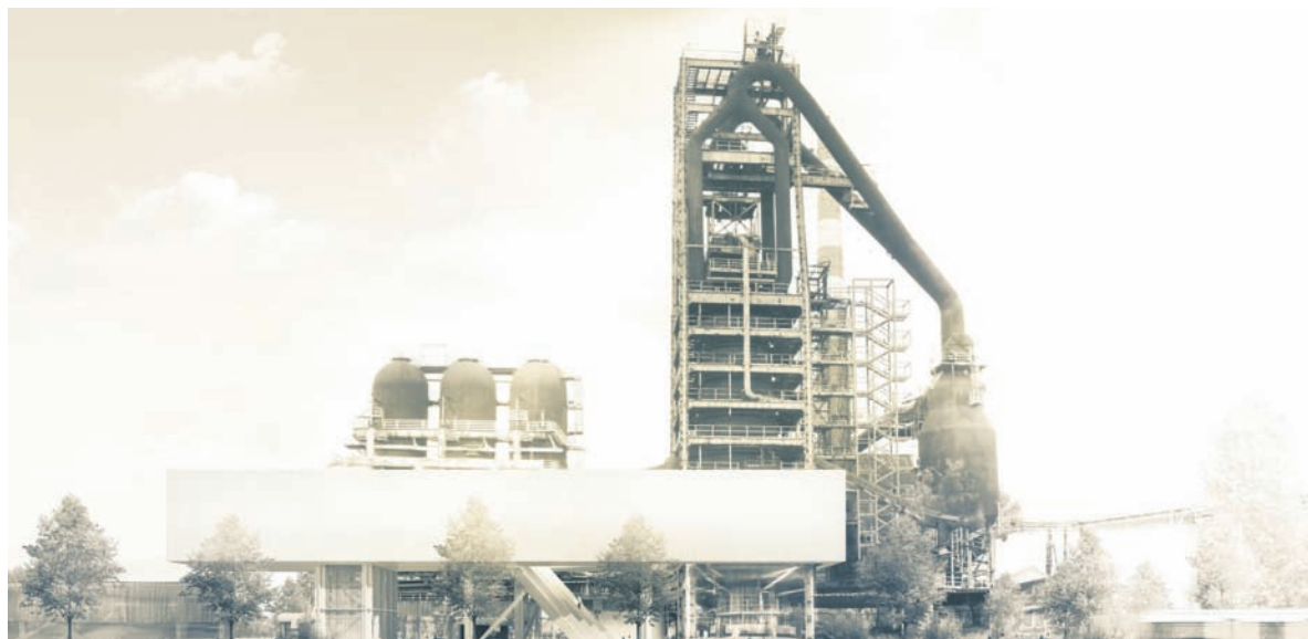
Główną atrakcją zrewitalizowanego Wielkiego Pieca ma być udostępnienie jego konstrukcji dla zwiedzających.
