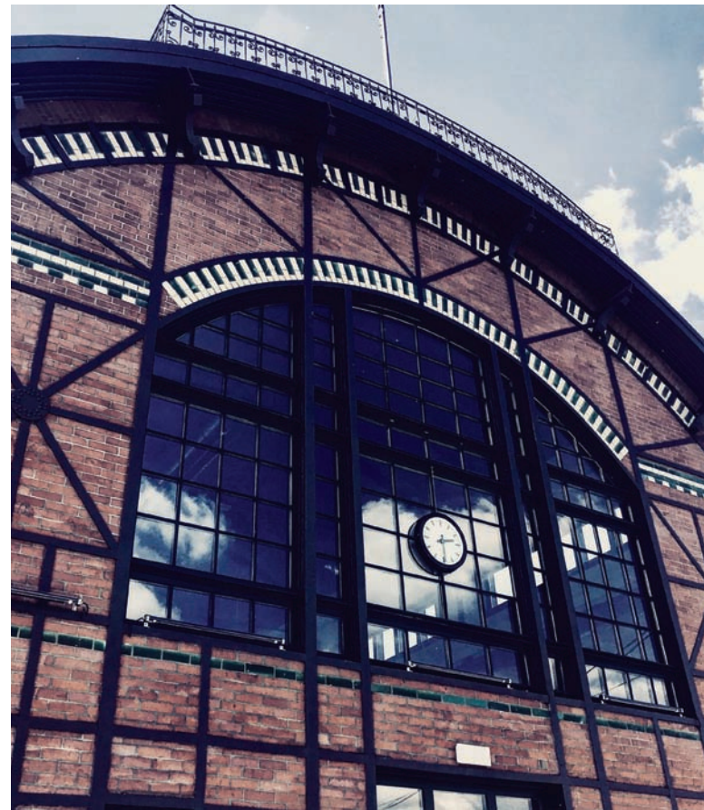
Koszt rewitalizacji i adaptacji dworca to ponad 8 mln zł.
