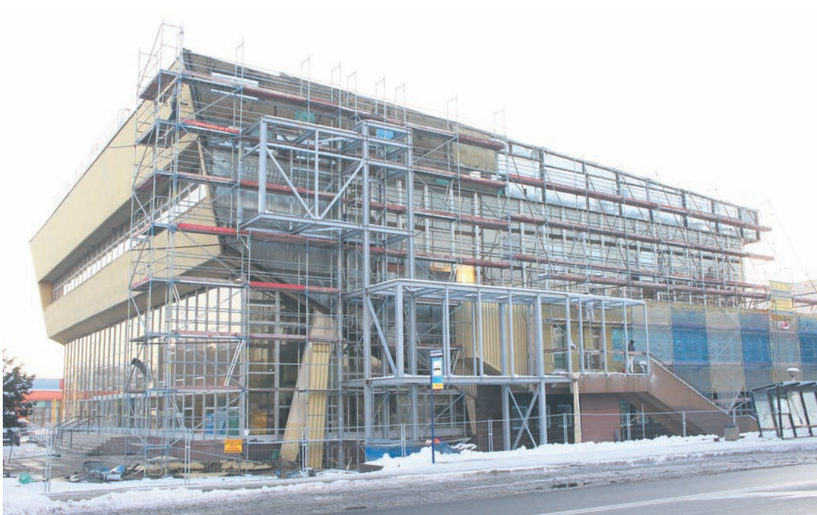
Wykonano już konstrukcję szybu windy i podjazd dla niepełnosprawnych.
