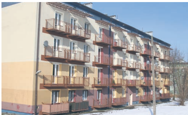
Przy ul. Solskiego 1-2 do budynków wspólnotowych po wniosku mieszkańców dobudowane zostały balkony.
