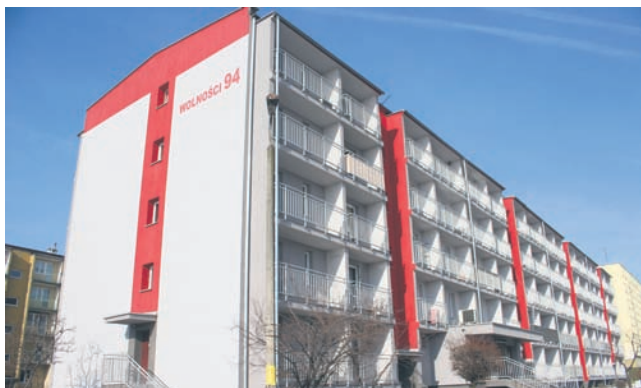
W ubiegłym roku z inicjatywy wspólnoty mieszkaniowej termomodernizowano budynek przy ul. Wolności 94.
