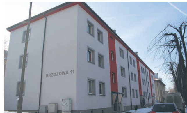
Jedną z „najświeższych” termomodernizacji wykonano przy ul. Brzozowej 11 w Kochłowicach.
