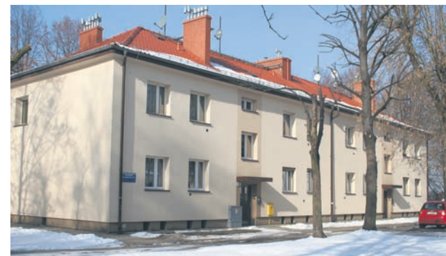
Termomodernizację w ubiegłym roku przeprowadzono również na budynkach przy ul. Maya 12 i 14.
