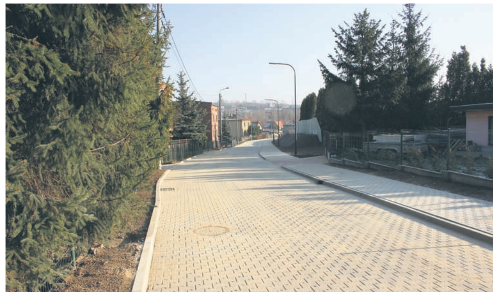
W ramach przebudowy ul. Reja wykonano nową nawierzchnię, chodnik, odwodnienie i oświetlenie LED.
