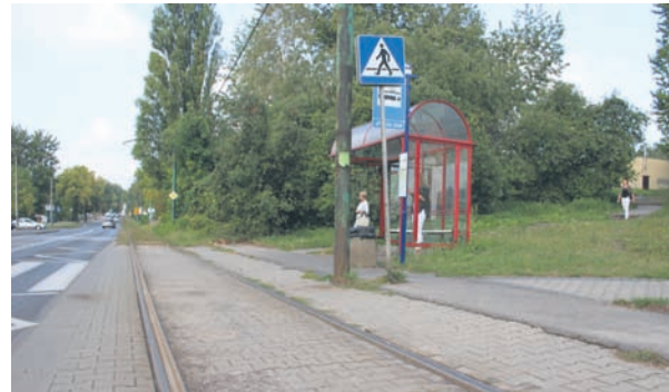
Różnica wysokości pomiędzy chodnikiem a torowiskiem zostanie wyrównana.
