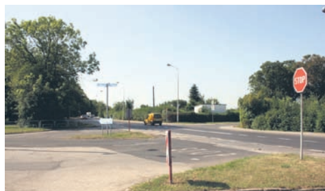
Budowa ronda na skrzyżowaniu ul. Wolności i Magazynowej
