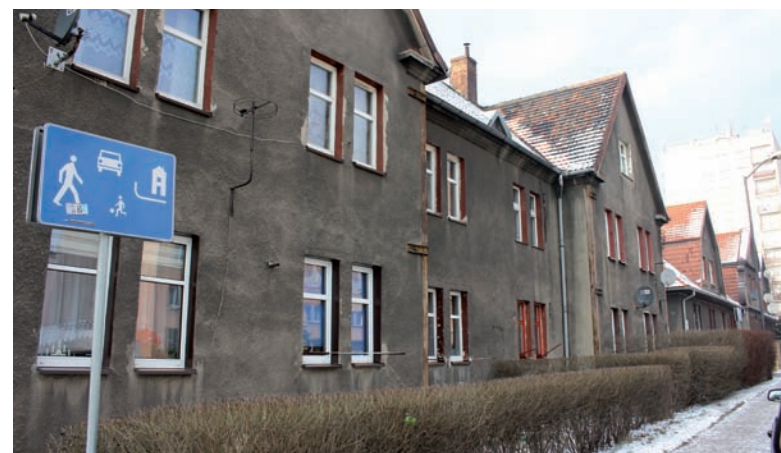
200 tys. zł przeznaczonych zostanie na dofinansowanie prac konserwatorskich dwóch budynków mieszkalnych przy ul. Raciborskiej 3 i 5.
