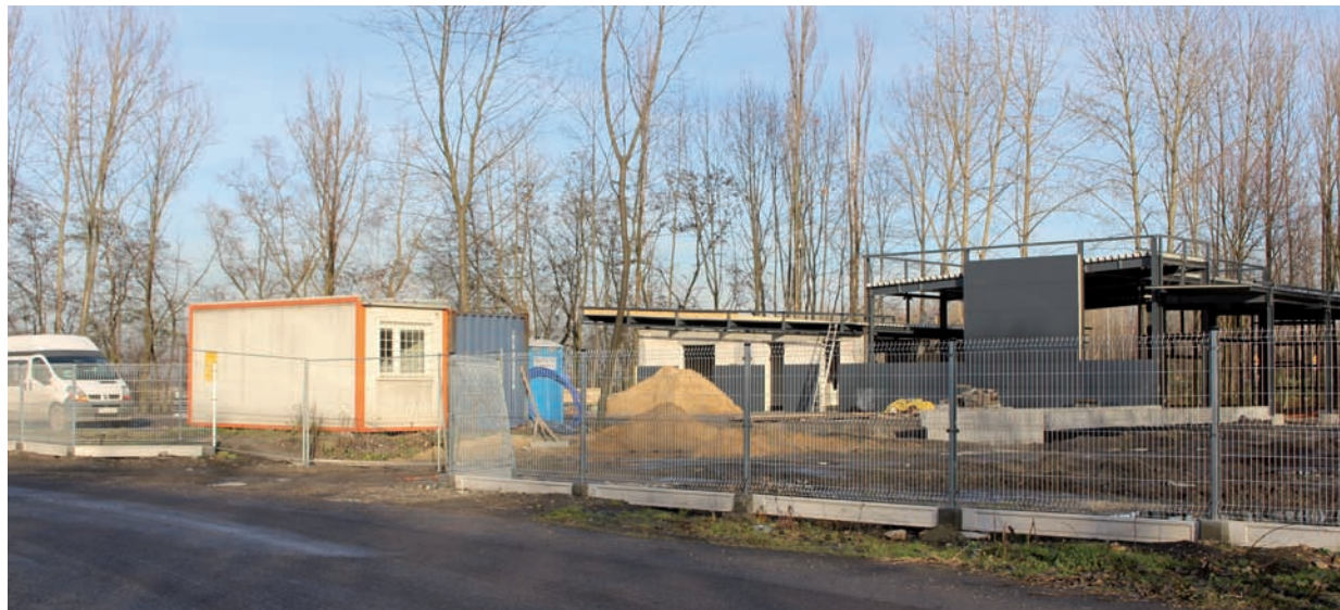
Budowa krematorium dla zwierząt już ruszyła.
