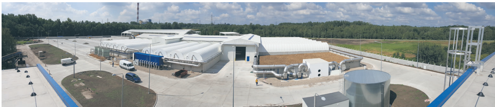
Kompostownia MPGK Sp. z o.o. w Katowicach.
