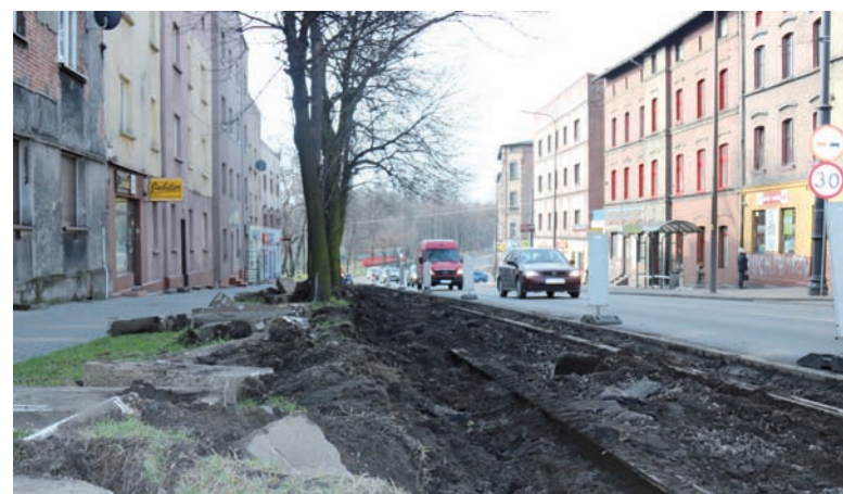
Modernizacja torowiska ma potrwać do jesieni.
