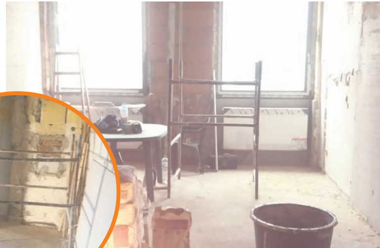
W przyszłej siedzibie Centrum trwa generalny remont.
