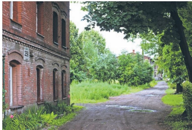
W tym miejscu zakończono prace rozbiórkowe.
