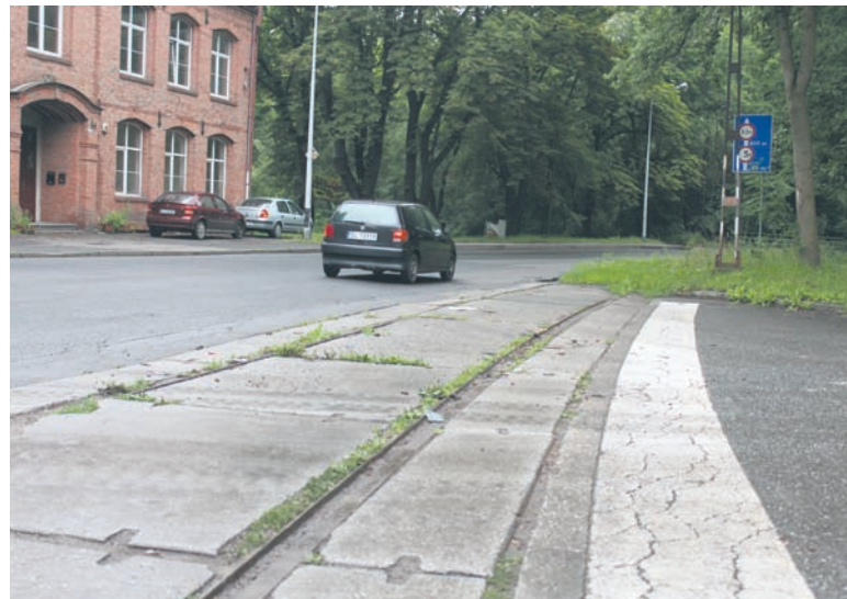
W ramach remontu tory zostaną zlikwidowane.
