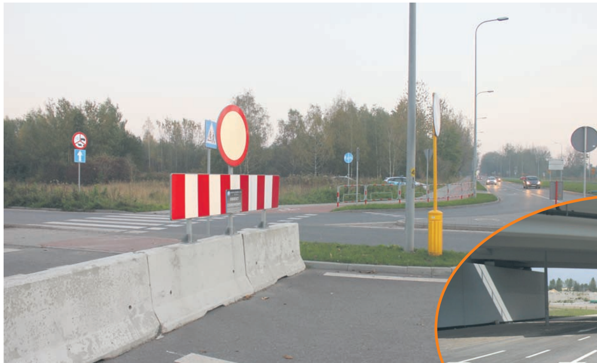
Po dwóch latach wznowiona zostanie budowa trasy N-S.
