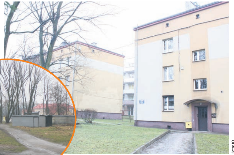
W miejscu drogi gruntowej pojawi się chodnik.
