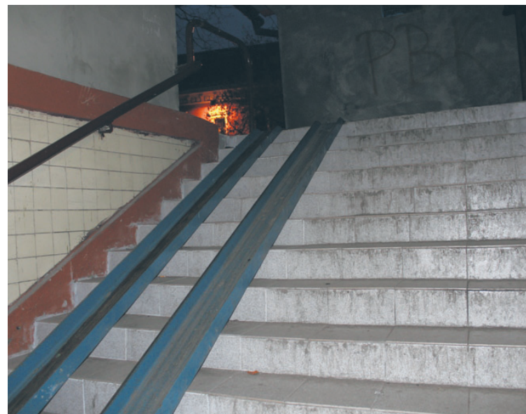
Podjazd w tunelu zamontowano w styczniu.
