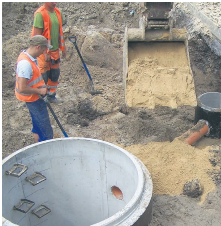
Obecnie w Rudzie Śląskiej budowana jest kanalizacja deszczowa przy ul. Kłodnickiej oraz w rejonie ulic Zabrzeńskiej i Kokotek.
