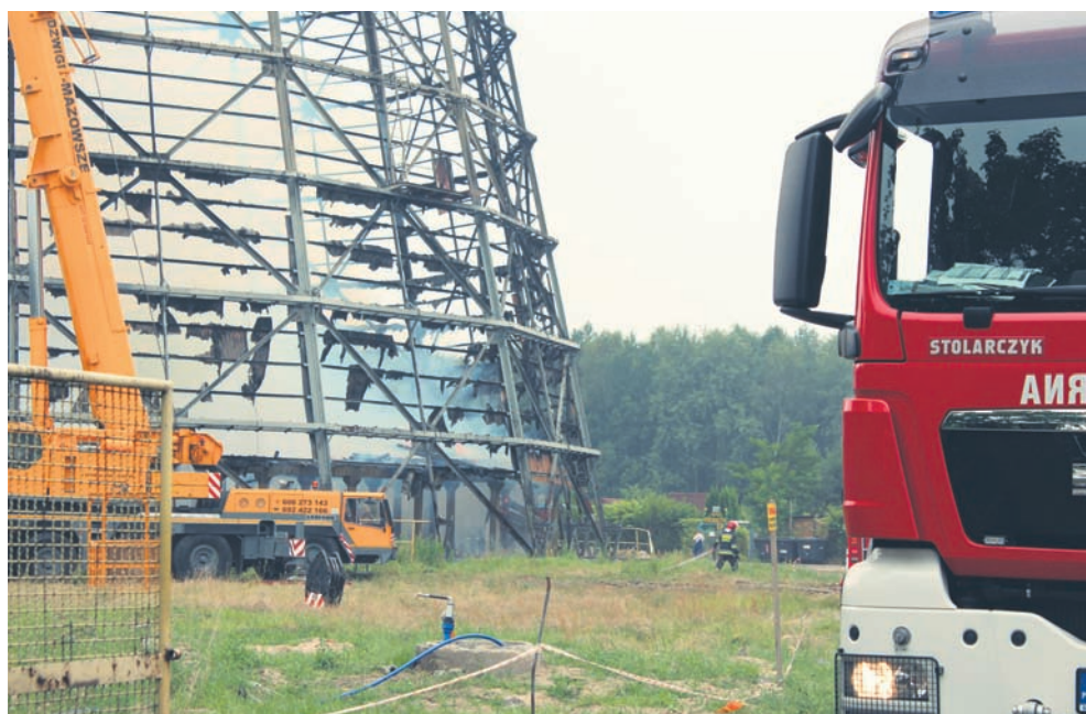
W lipcu pożar wybuchł podczas prac rozbiórkowych.
