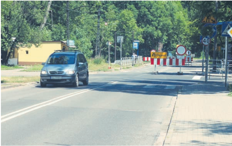
Roboty drogowe wciąż denerwują przejeżdżających tamtędy kierowców.
