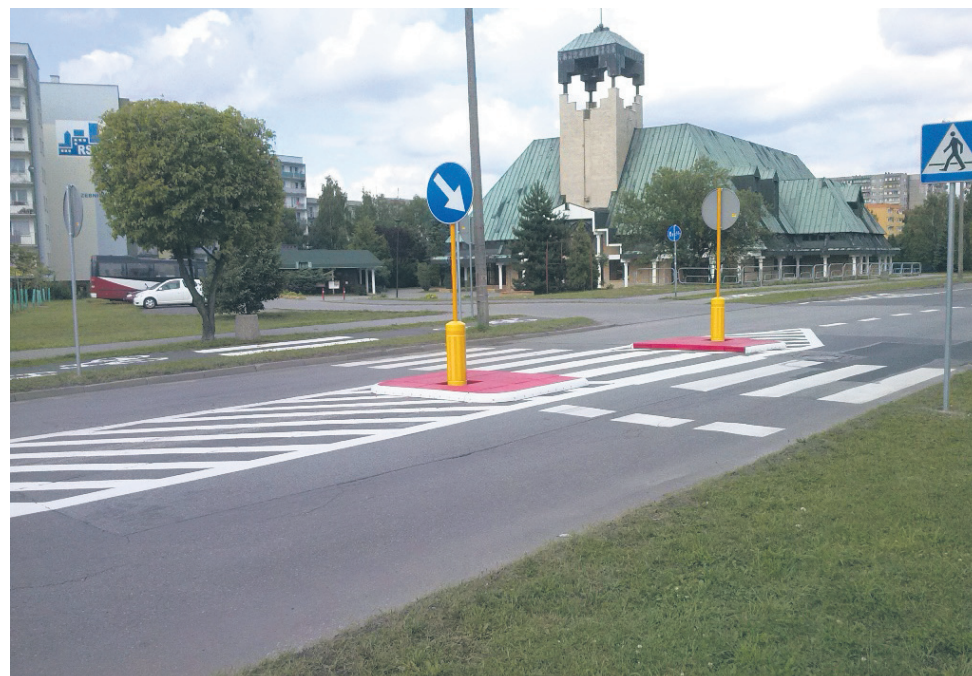
Zwężenie jezdni ul. Górnośląskiej ma poprawić bezpieczeństwo na drodze.
