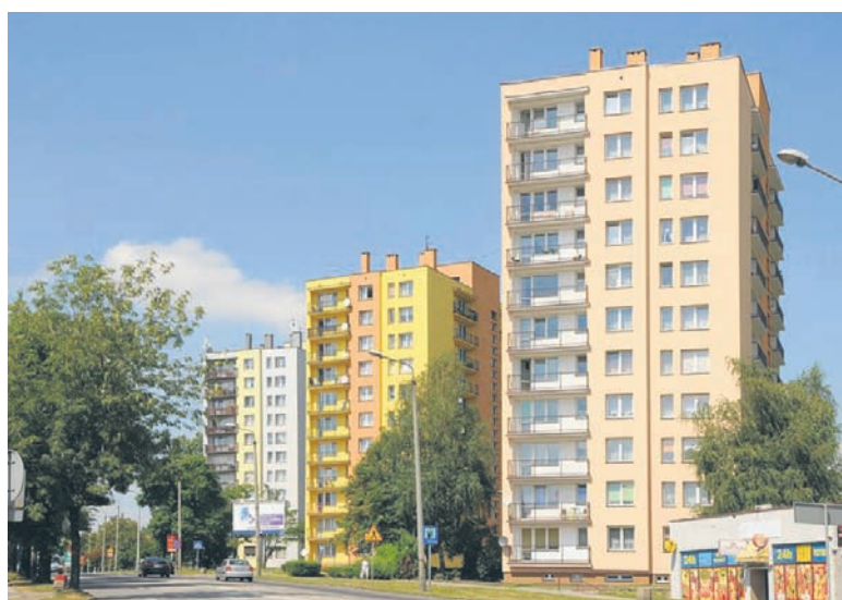
Budynki MPGM po termomodernizacji.
