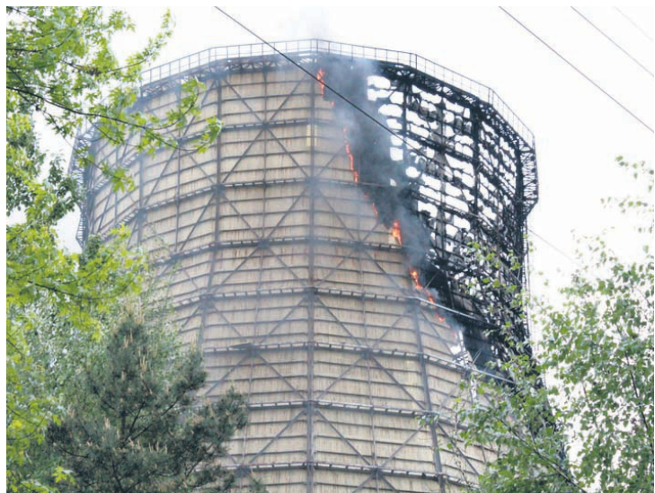
Palić zaczęło się ocieplenie ściany komina chłodniczego.
