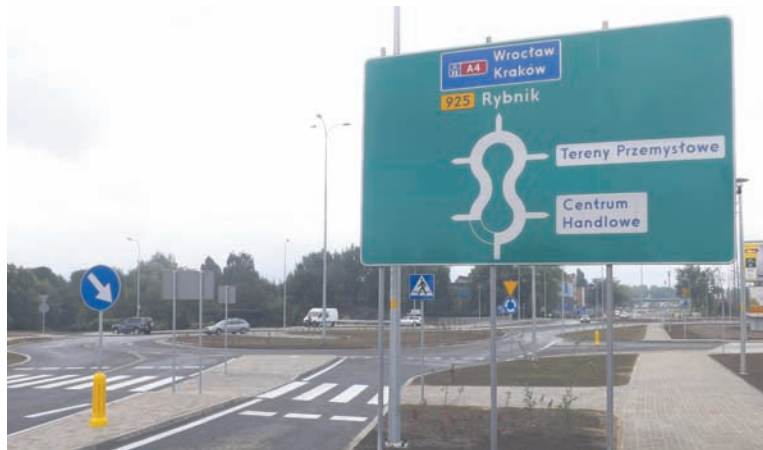
Przebudowa ul. 1 Maja na odcinku od ul. Klary do ul. Szyb Walenty kosztowała miasto 8,7 mln zł.
