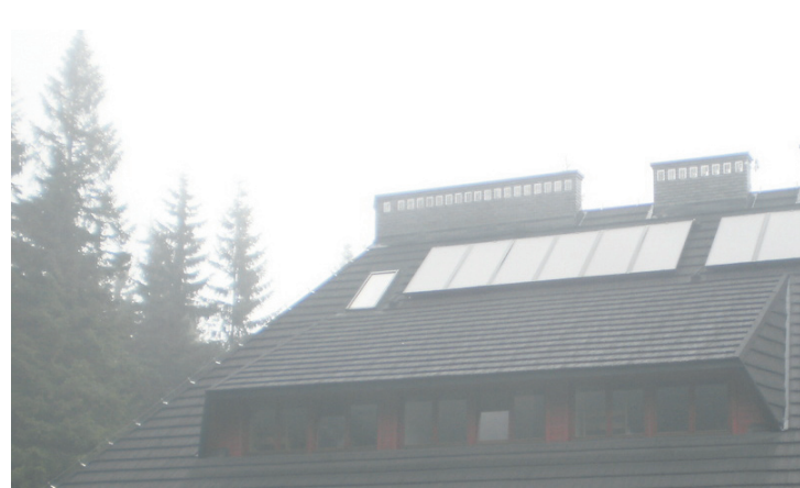
Zakładanie kolektorów słonecznych.
