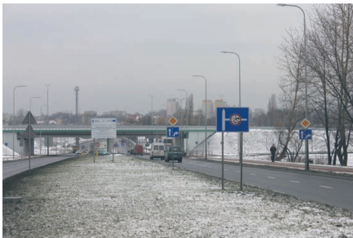
Na budowę trasy N-S zabezpieczono ponad 13 mln zł.
