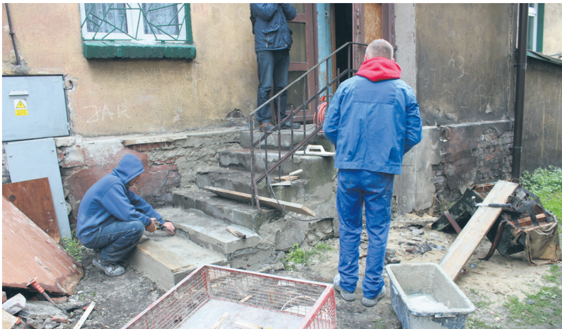
Osoby bezrobotne remontują schody przy ulicy Chorzowskiej.
